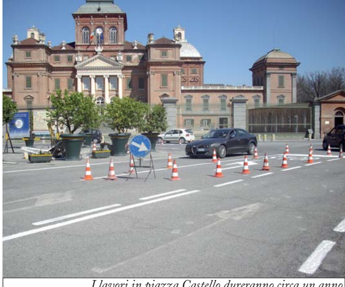
I lavori in piazza Castello dureranno circa un anno
