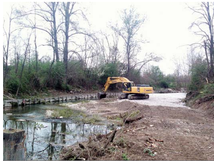
Ruspe al lavoro nel primo tratto interessato dall'intervento
