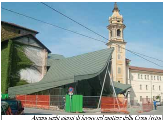
Ancora pochi giorni di lavoro nel cantiere della Crosa Neira
