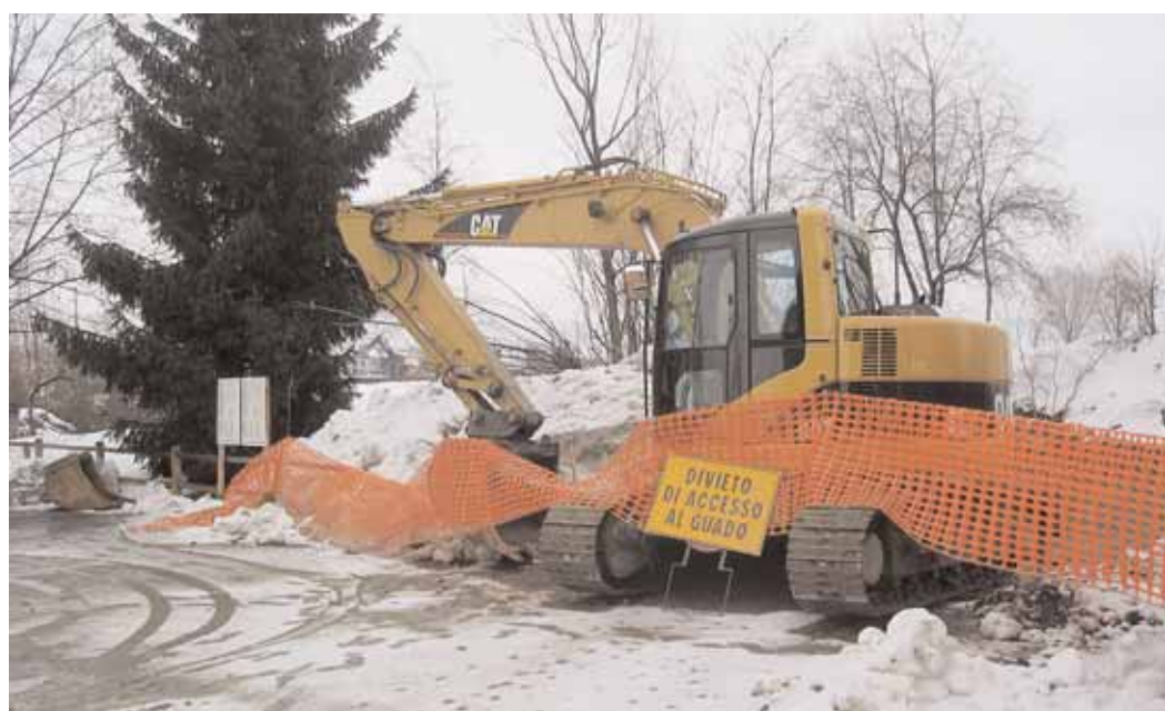
Il cantiere sul Mellea aperto in questi giorni: l'intervento provvisorio sulle sponde durerà un mese e mezzo
